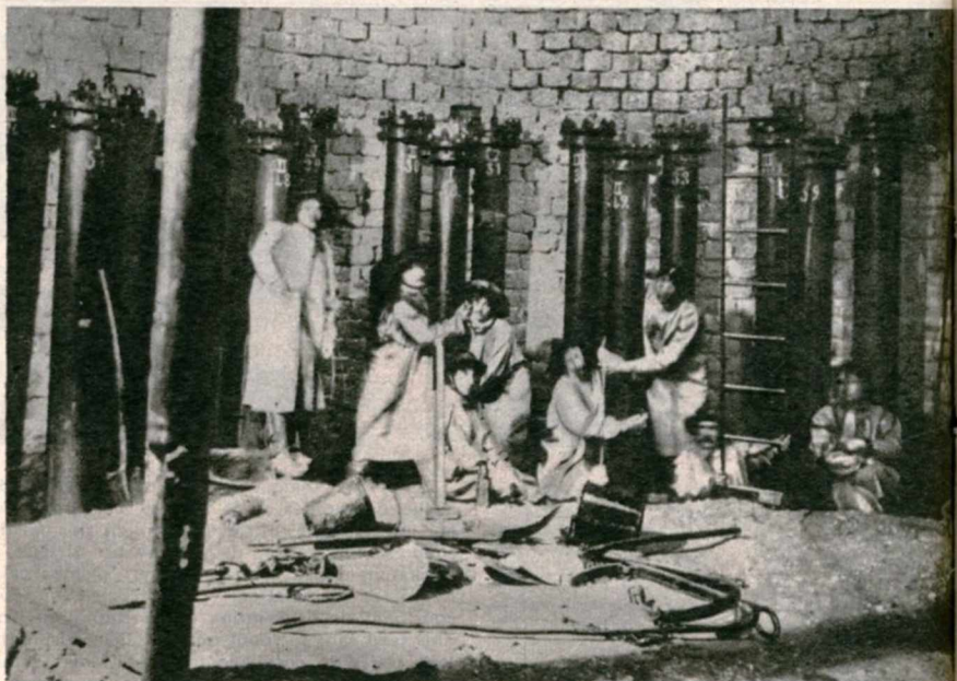
SIEGE DE WATERSCHEL Puits n° 1, congélation des sables. Entrée de la tranchée annulaire d'établissement des tubes guidés à 466 mètres de profondeur.
